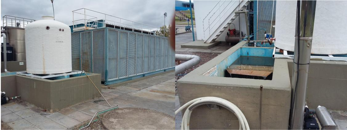
Imagen 20: Cámara de cloración. Izquierda: vista de la cámara y del tanque con Hipoclorito para dosificación. Derecha: detalle salida del efluente. Fuente: fotografías propias, 2017.
