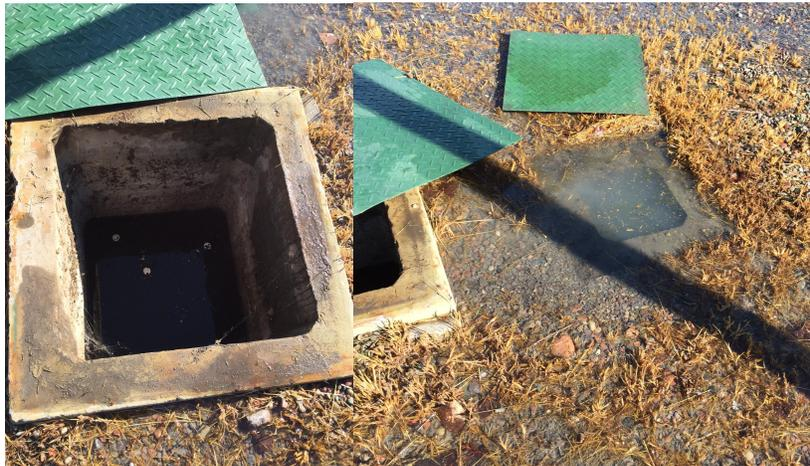
Imagen 16: Cámara de inspección. Izquierda: vista del componente sin rebalses. Derecha: vista de la cámara luego de una precipitación torrencial. Fuente: fotografías propias, 2017.
