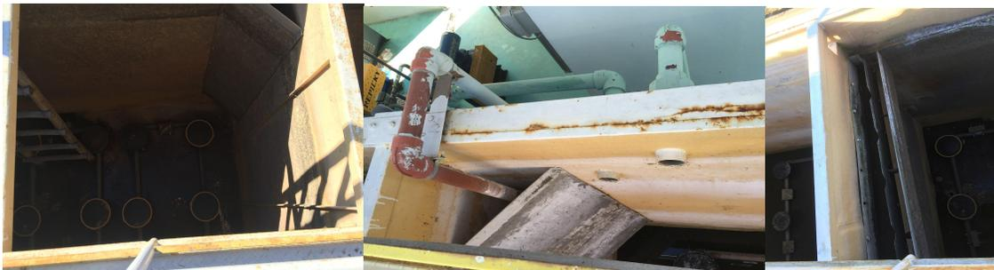
Imagen 19: Unitanques. Arriba: cuadro de maniobras. Abajo izquierda: aireadores disco de microburbujas. Centro: detalle de ingreso de efluente al unitank. Derecha: vertedero multi "V" para el paso de efluente. Fuente: fotografías propias, 2017.
