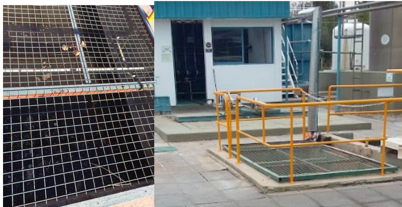
Imagen 17: Digestor anaeróbico secundario. Izquierda: detalle de la malla de contención; se observan sólidos flotando dentro del digestor. Derecha: vista completa del digestor con malla y baranda de seguridad. Fuente: fotografías propias, 2017.
