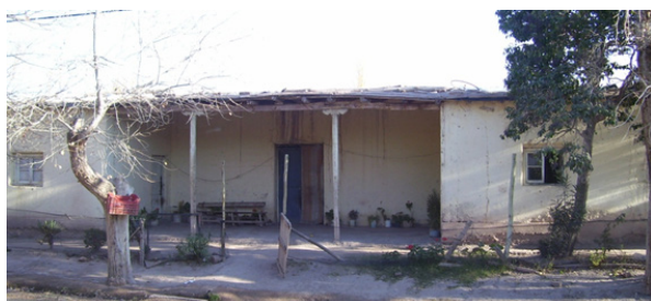
Figura 13:Foto del bien MP07E4183 -Vivienda Circundante Al Este De La Capilla (1885 c). Maipú Barrancas.
