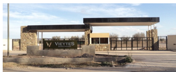
Figura 20: Foto del portal de acceso a barrio privado en la Ruta Provincial N° 60 en el distrito rural de Cruz de Piedra, Maipú – Mendoza, Argentina.
