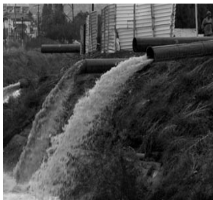
Fig. N° 13. Vertido aguas negras a cauce abierto
