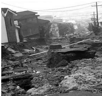
Fig. N° 23. Calle Pedro de Mendoza, Colonia Cumbres, Cerro de las Mitras, Monterrey, N.L.
