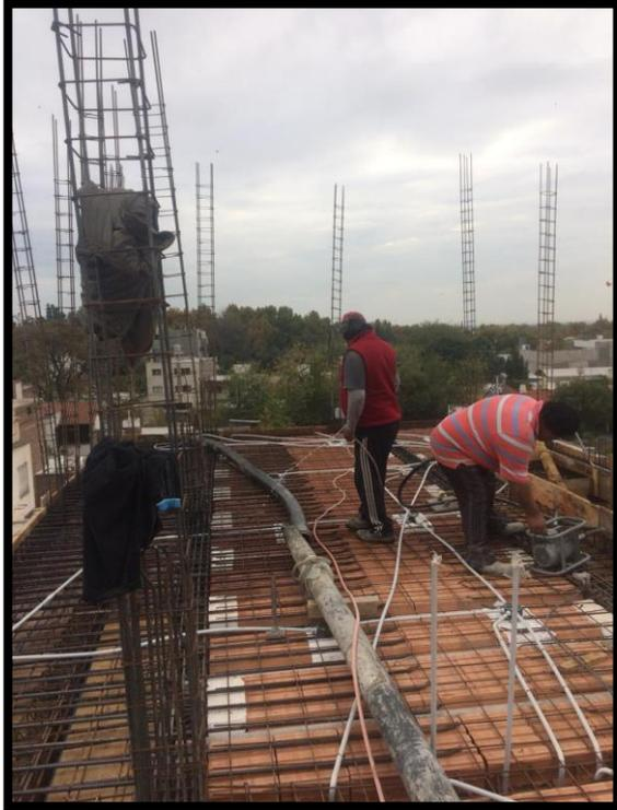
*Imagen N° 14 Llenado de Losa cuarto piso*
