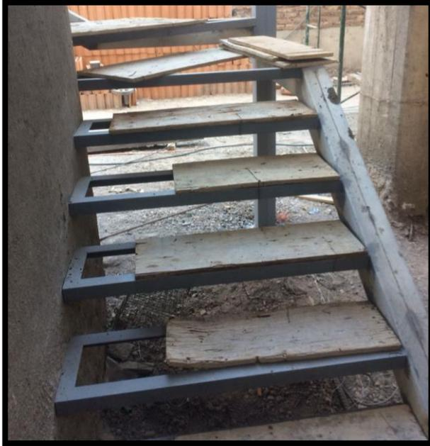
*Imagen N° 21 Colocación de Fenólicos a escalera metálica*
