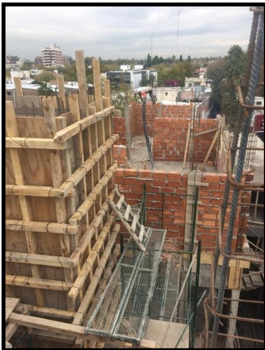
*Imagen N° 13 Encofrado tabique de Ascensor*
