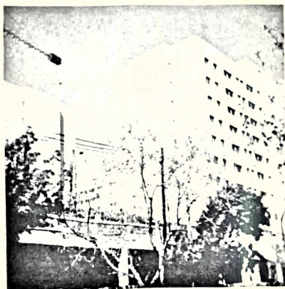
Fot. 5 — La presencia de los conjuntos monobloques en el centro de la ciudad (Avenida San Juan esquina República de Siria).
