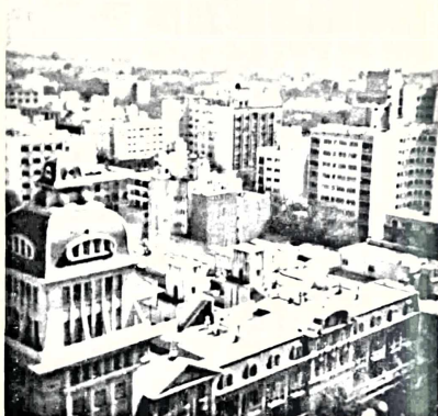
Fot. 8 — Vista del área de concentración del crecimiento tridimensional. Esta aquí el primer exponente junto al continuo progreso (avenida General San Martín esquina avenida Sarmiento).
