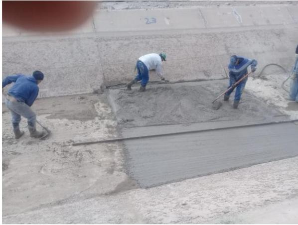
Se realiza el mecanismo de regulador, para tener una superficie plana al pasaje del agua
