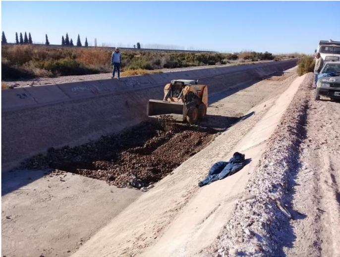
Primero se destruya la losa existente, se saca los gravas, (se puede colocar 2 tuberías de drenaje y)
