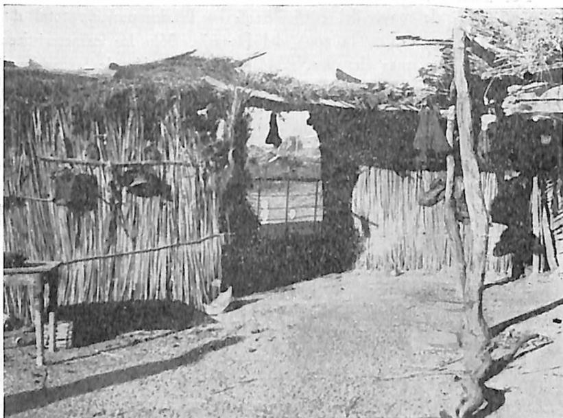
FIG. 3 - Vivienda natural en Las Hormigas. Integramente de junquillo, con armadura de algarrobo y álamo (Fot. Fidel A. Roig Simon - 26 - V - 51).
